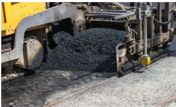
> Las obras incluirán actuaciones complementarias como el ajuste de tapas y arquetas.
