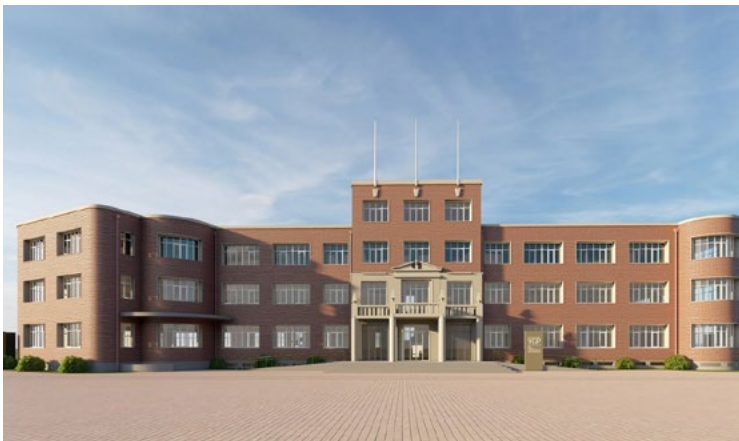
> La empresa VGP va a ser la rehabilitación de estos edificios históricos.
