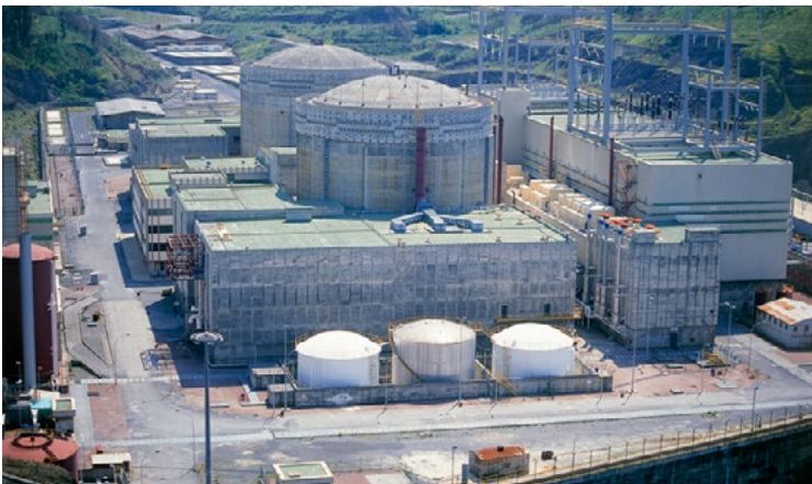
> La cesión permitirá iniciar la adecuación de las instalaciones para futuros proyectos.
