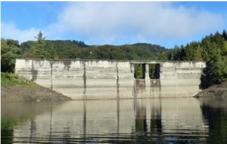
➤ También se va a colocar un marco de hormigón en el cauce de la regata Enobieta.
