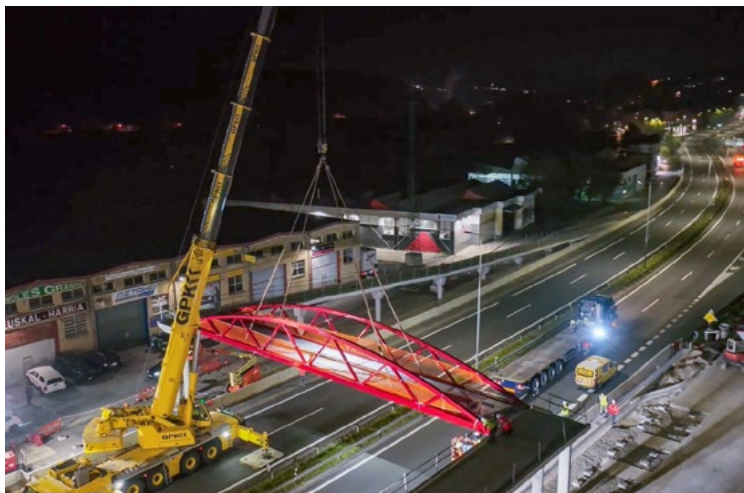
➤ Se trata una estructura metálica en arco con losa de hormigón.
