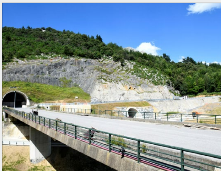
Licitado el tendido de la catenaria de la Y vasca
