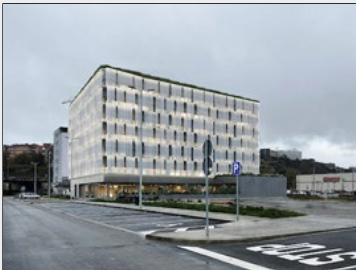
Sprilur licita las obras del futuro Polo Sanitario de Sestao.
