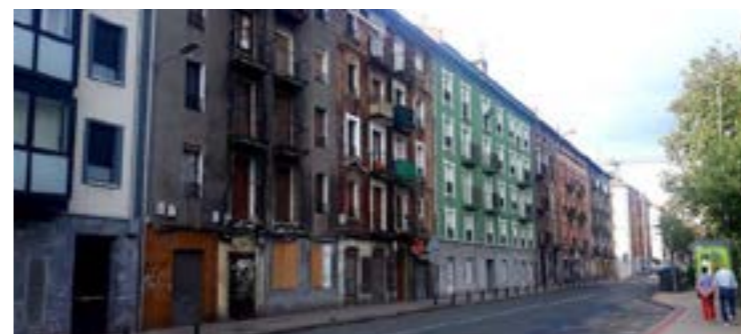
► Las nuevas viviendas irán conectadas al district heating de Txabarri.
