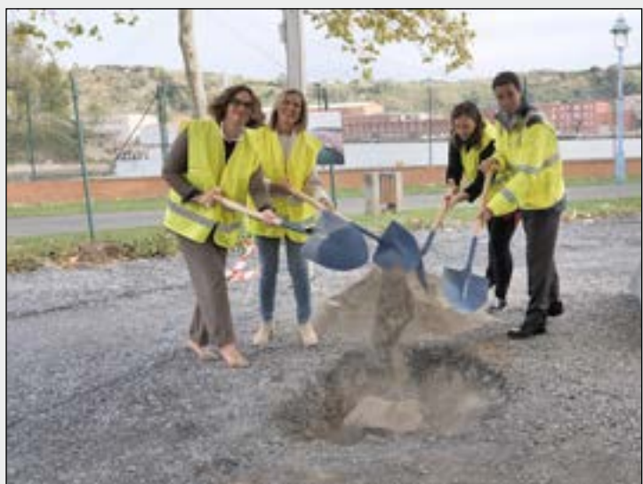
Arrancan las obras del puente que unirá Barakaldo y Erandio > P. 4
