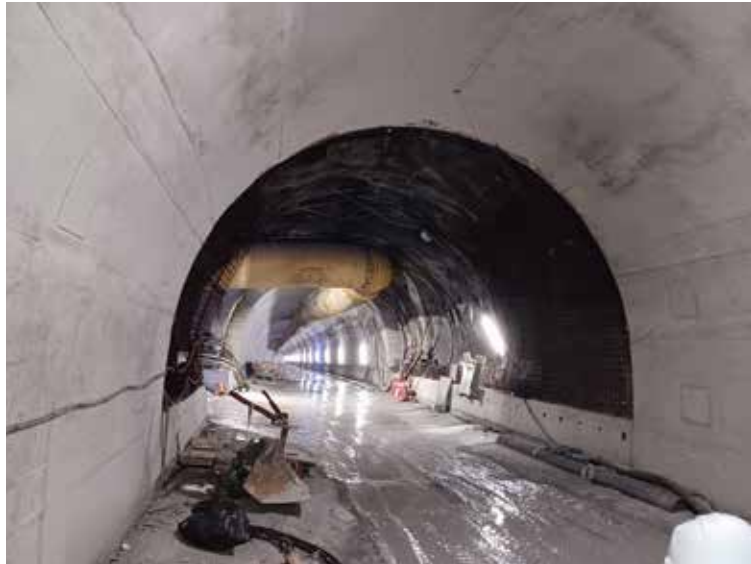
➤ Se ejecutará un desvío para permitir la construcción del falso túnel de conexión de Morlans.
