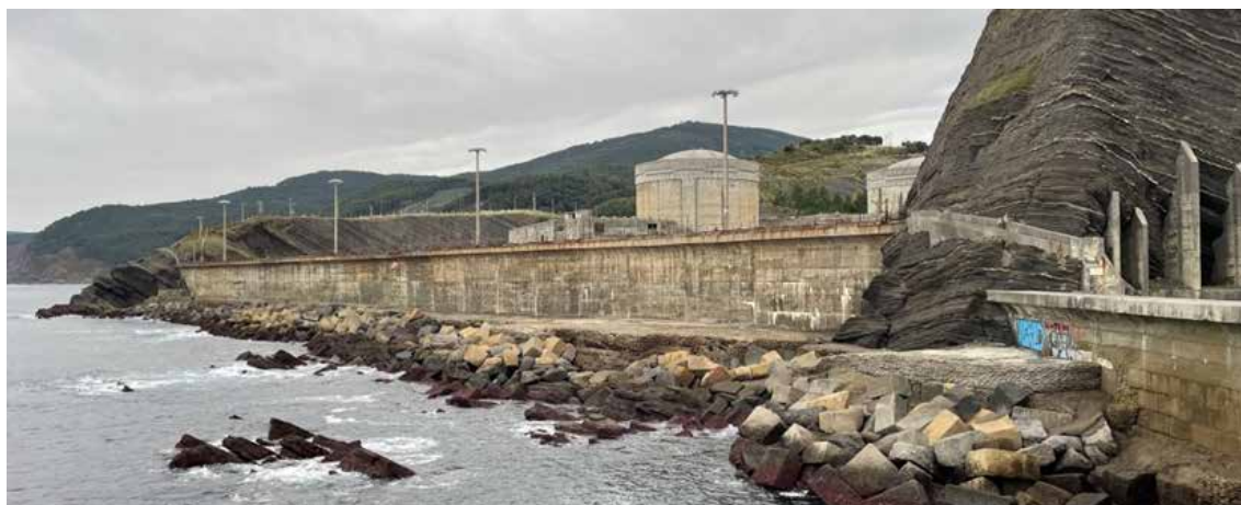
► Los trabajos requerirán de la colocación de 415 bloques de hormigón de alta densidad, de 45 toneladas de peso.
