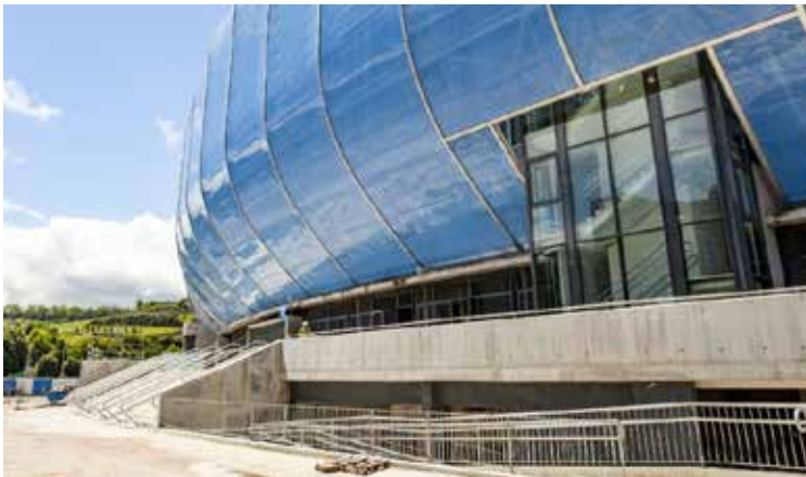
► La Junta de Gobierno ha adjudicado las dos primeras fases de estos trabajos.
