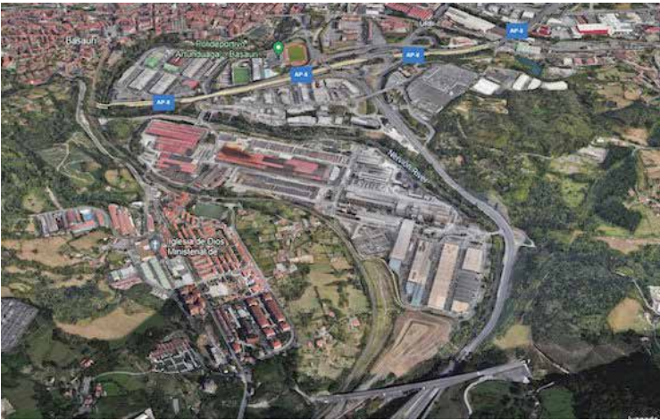
► El importe de los trabajos asciende a 511.872 euros y un plazo de ejecución de 18 meses.
